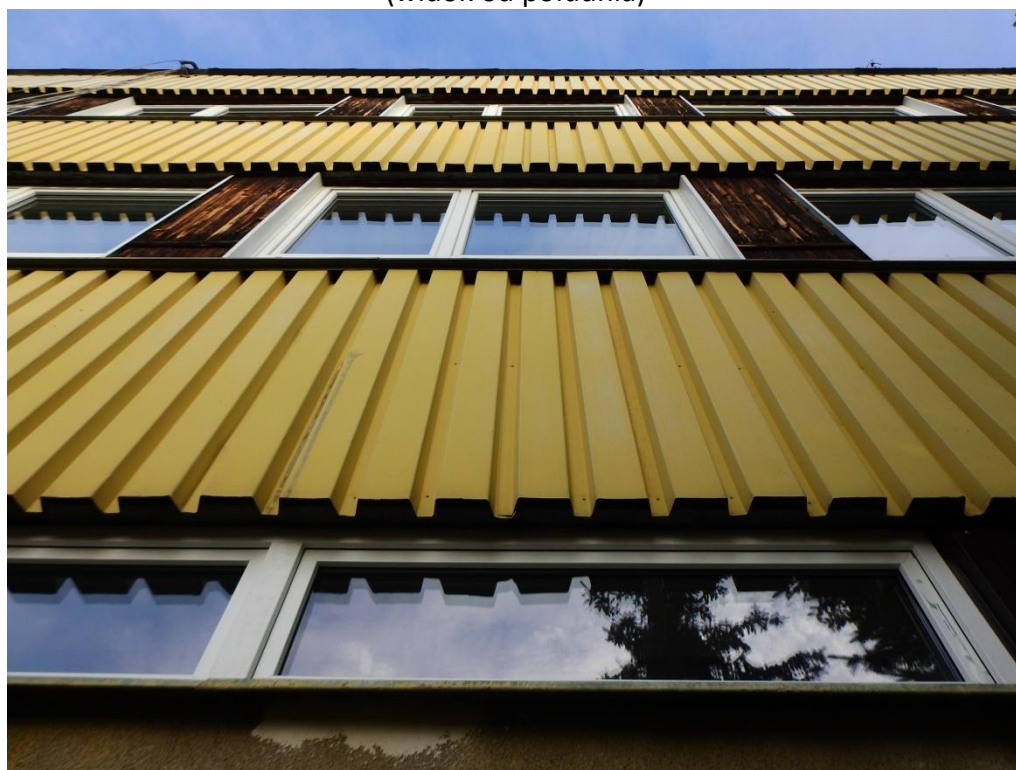
Fot. 2. Znaczna część elewacji budynków szkoły wykonana jest z blachy i desek
