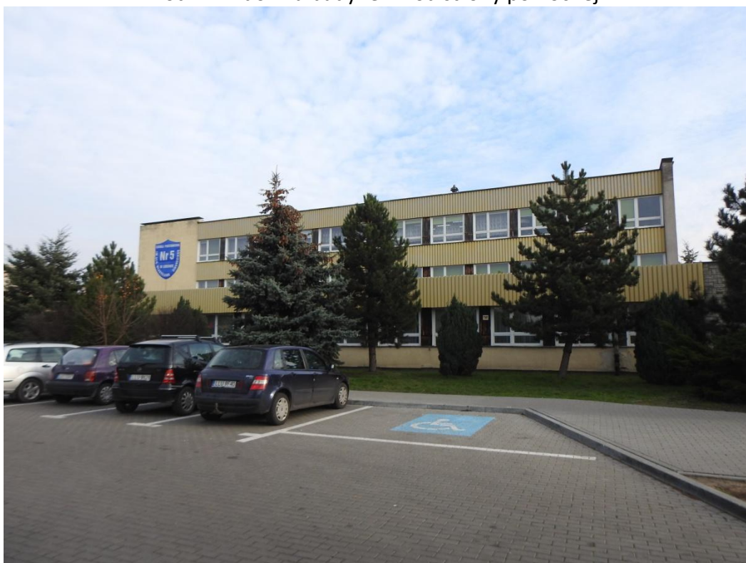
Fot. 8. Budynek A od strony parkingu i ulicy Siedleckiej (strona zachodnia)
