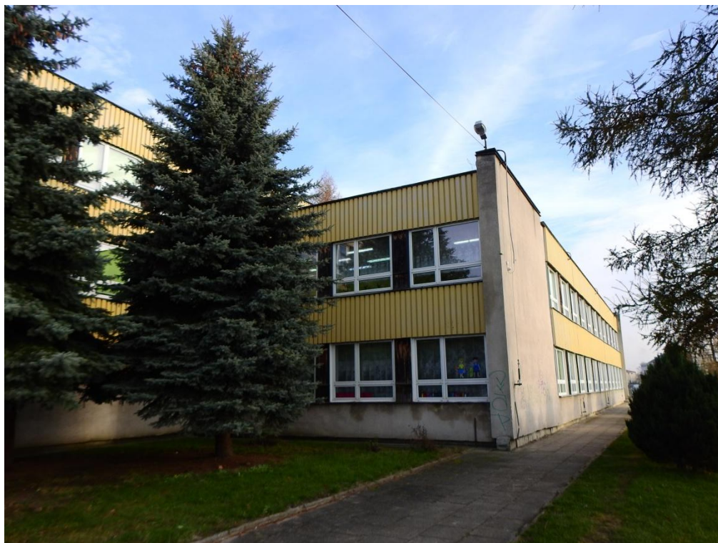
Fot. 3. Widok na budynek C
